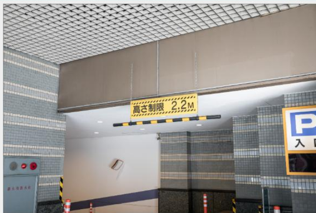
地下駐車場入り口 高さ制限2.2m
